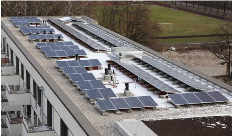
Abbildung 2: Die individualisierte Ausrichtung der Module modelliert den Strombedarf im Gebäude und optimiert damit den Eigenverbrauch.
