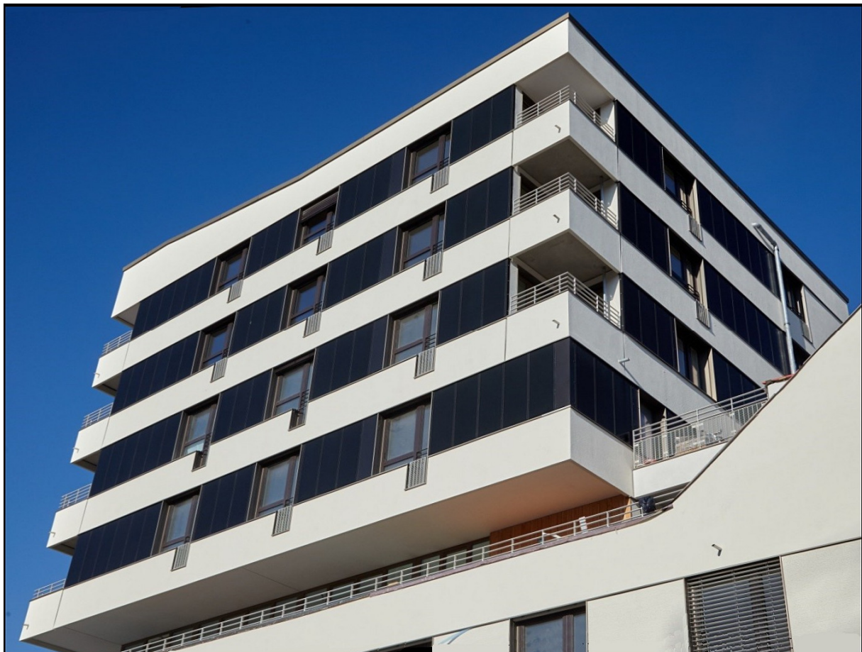
Abbildung 1: Die Module an der Fassade sind als solche nicht zu erkennen, ermöglichen aber mit der Stromversorgung über die Flachdächer eine weitere Steigerung des Eigenverbrauchs.
